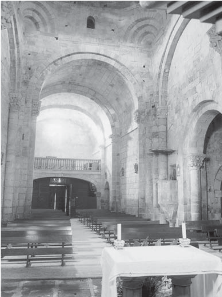
Figura 26. Colegiata de Sta. Cruz de Castañeda (Cantabria), de nave única con crucero elevado con luces y cúpula sobre trompas. Las alas del transepto (de las que sólo queda una original) se abren a la nave a través de arcos doblados de medio punto, formando capillas semiindependientes (foto: Arriola).
