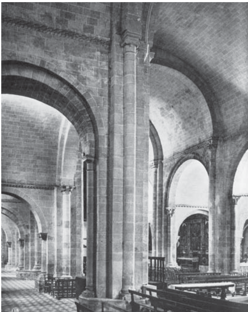
Figura 18. Catedral de Nôtre-Dame de Lescar, vieja capital de Bearn, situada en la periferia de la ciudad de Pau. Aquí los pilares compuestos son de núcleo cruciforme y las naves laterales se cubren con bóvedas de cañón en sentido transversal (variante del modelo basilical) construida a principios del siglo XII (foto: Zodiaque).
