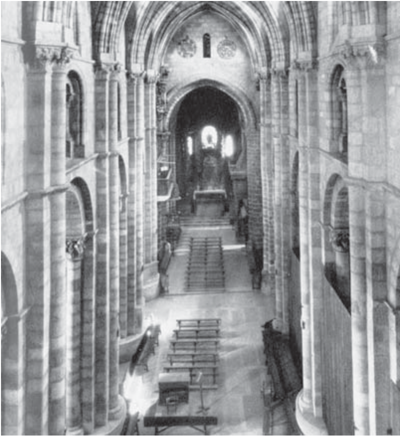
Figura 28. Iglesia de San Vicente (Ávila). Nave elevada a mediados del siglo XII con las pautas arquitectónicas de la Peregrinación. Pilares compuestos de núcleo cuadrado y piso alto (tribunas) al estilo de los Grandes Santuarios del Camino. La cubierta de la nave de bóvedas apuntadas y nervadas pertenecen ya al primer período gótico que difundieron por España los cistercienses.
