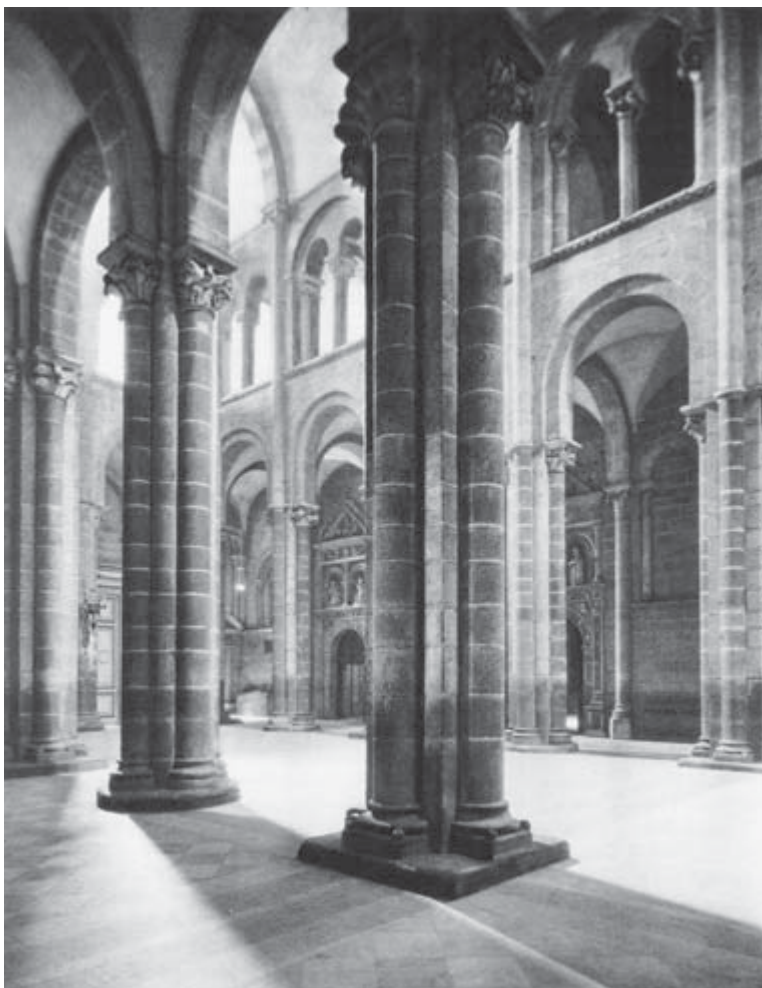
Figura 15. El pilar compuesto de núcleo cuadrado, fundamento de la basílica de Santiago de Compostela, experimentada antes en Conques y en Nevers.
