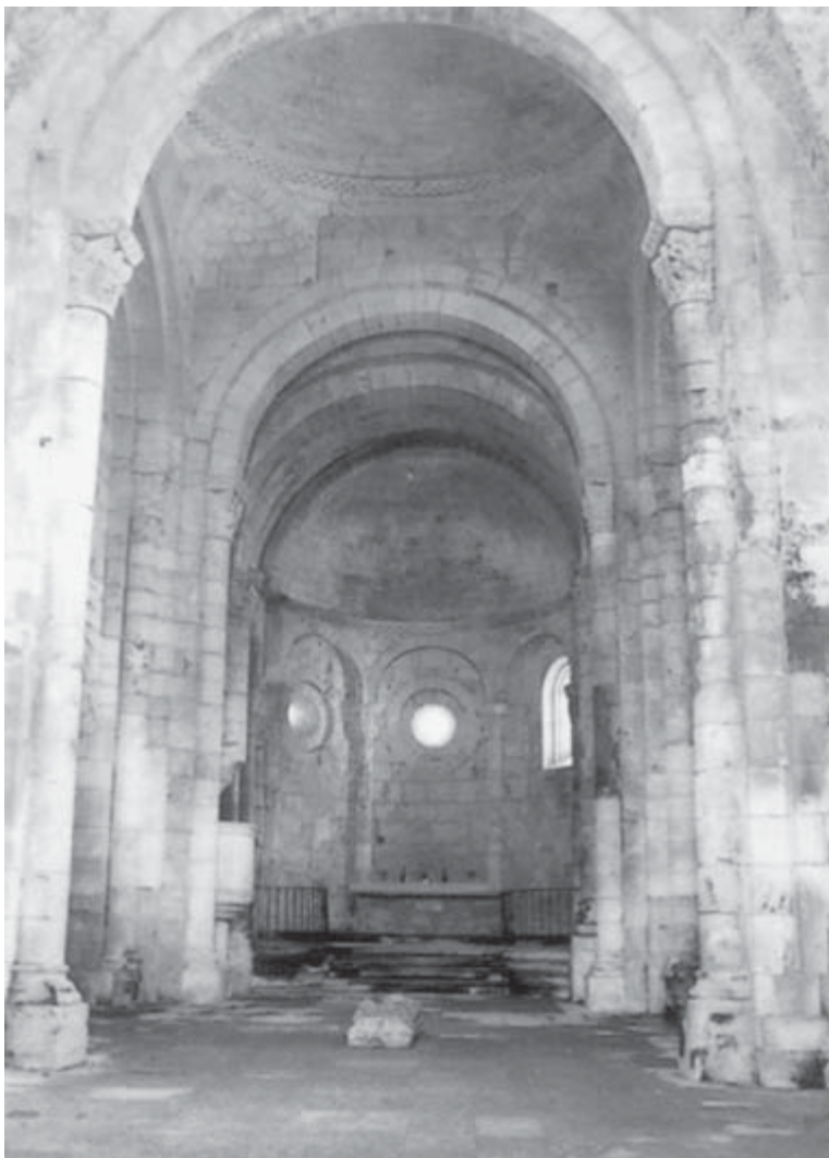
Figura 25. San Quirce de los Ausines en las proximidades de Burgos, de nave única (sin alas) y crucero con cúpula sobre trompas. Esta iglesia es de las primeras de la peregrinación, porque se sabe que Fernando I visitó las obras en 1054 (foto: J. Sáiz).
