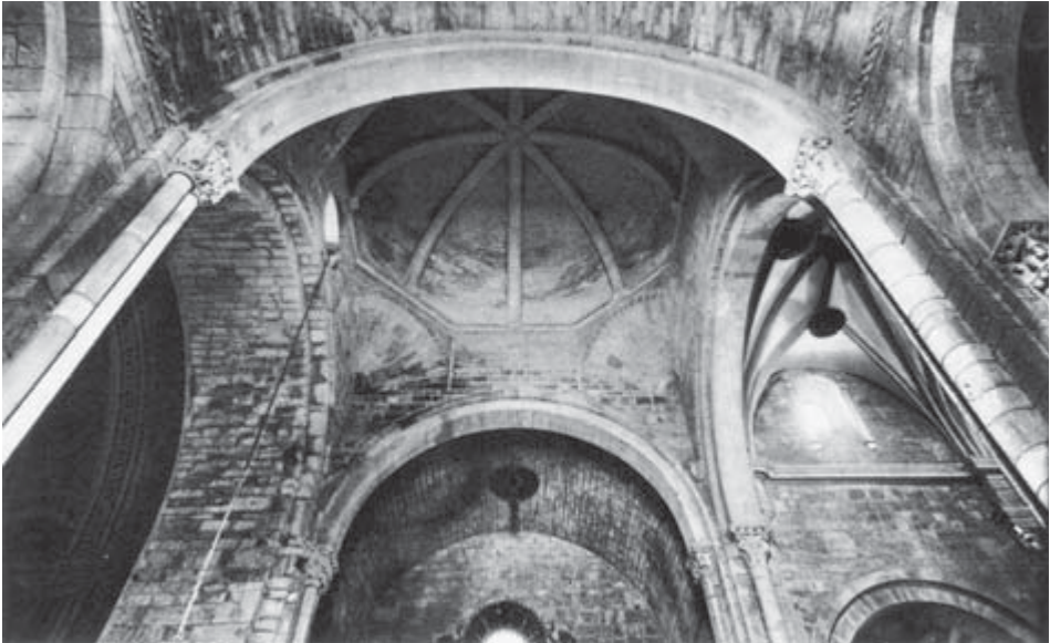
Figura 9. Crucero de la Catedral de Jaca, que se cerró con cúpula nervada de ejecución mozarabe. Pilares compuestos embutidos en las esquinas del mismo.
