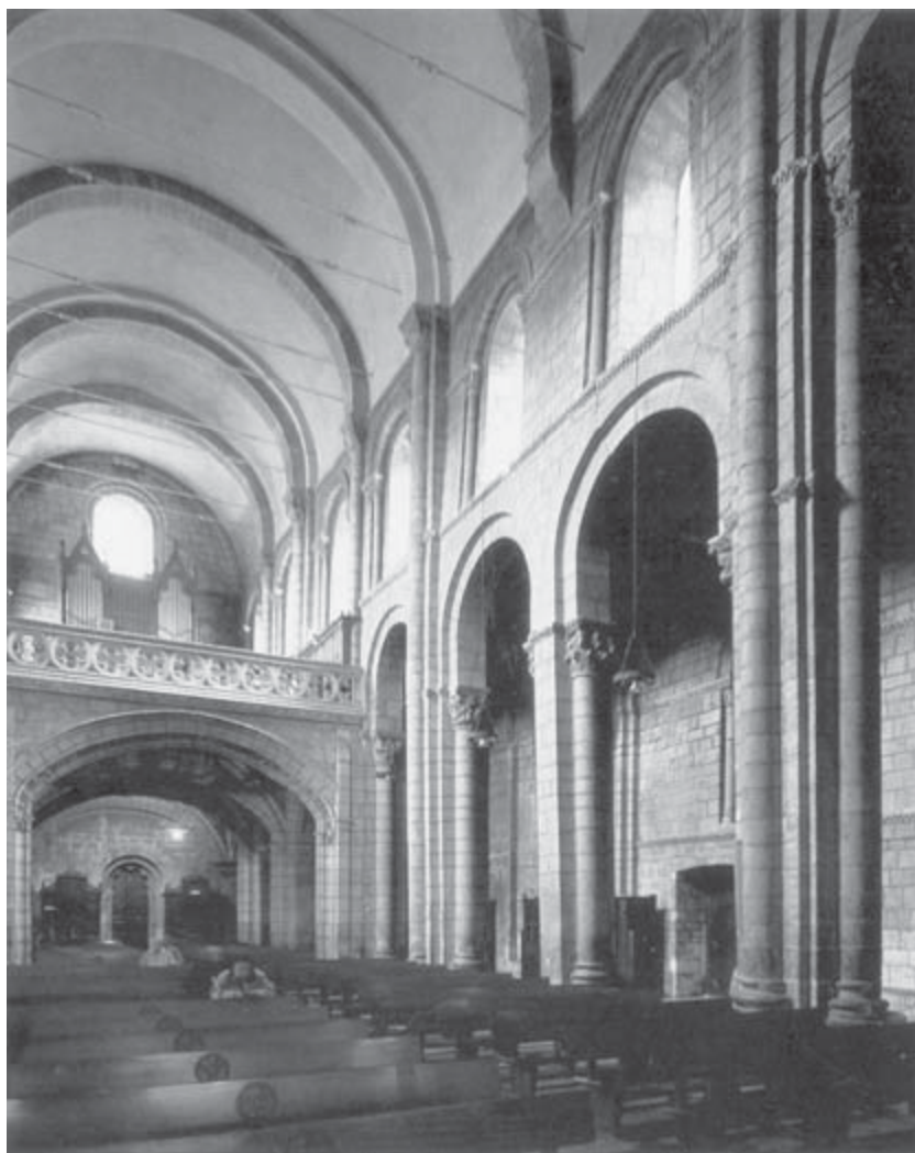
Figura 21. Nave central de San Isidoro de León con un coro gótico al fondo construido en el siglo XIV. El sistema alternativo de soportes —al estilo de la catedral de Jaca—, hace también suponer que se pensó para ser cubierto con bóvedas lombardas de planta cuadrada ocupando cada uno dos tramos, y posteriormente se realizó de cañón seguido, con arco fajón intermedio arrancando de ménsulas superpuestas.
