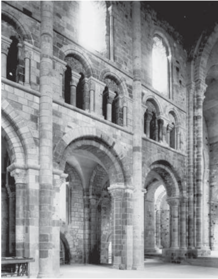
Figura 11. Alzado interior de la abadía Mont St. Michel , precursora de los Grandes Santuarios del Camino y fundamentado en el pilar compuesto de núcleo cuadrado.
