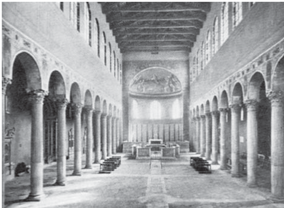
Figura 2. La basílica cristiana primitiva, apoyada siempre sobre columnas exentas (Sta. Sabina del Aventino).
