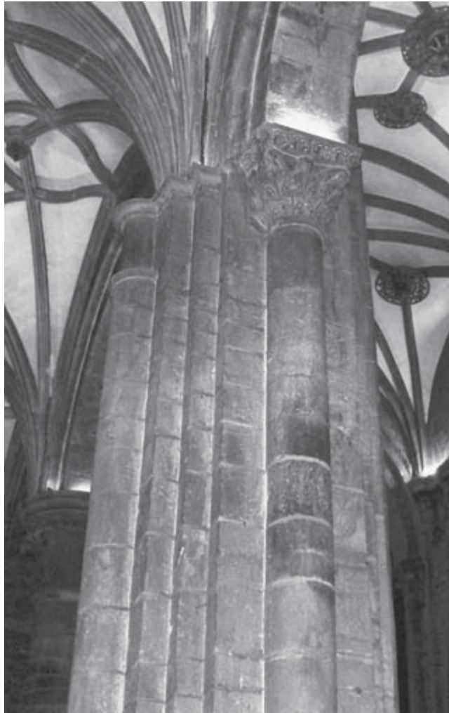
Figura 10. Pilar compuesto de núcleo cruciforme de doble esquina en la Catedral de Jaca , concebido para recibir fuertes cargas alternando con columnas exentas (modelo llamado «alternativo») (foto del autor).
